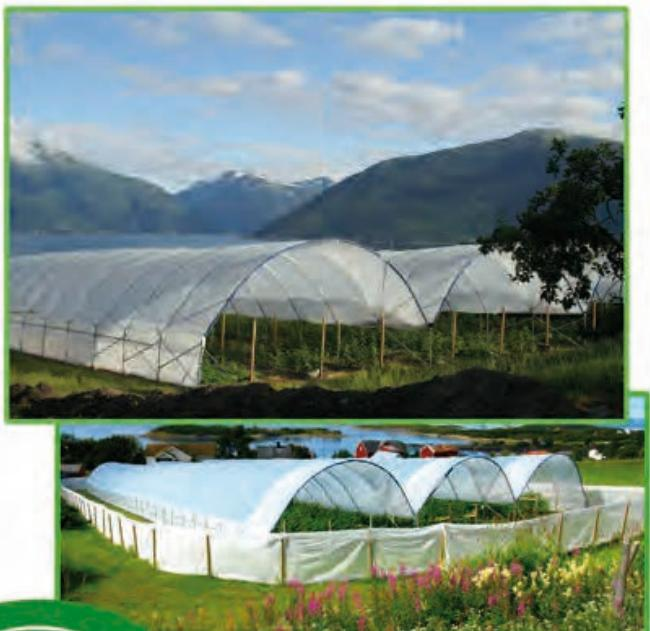
Vår standard tunnel, den vi har hatt siden 2008. Sterk mot vær og vind, og med mange alternative løsninger, tilpasset lokale vind- og værforhold. Kan leveres med flere forskjellige type dører.
